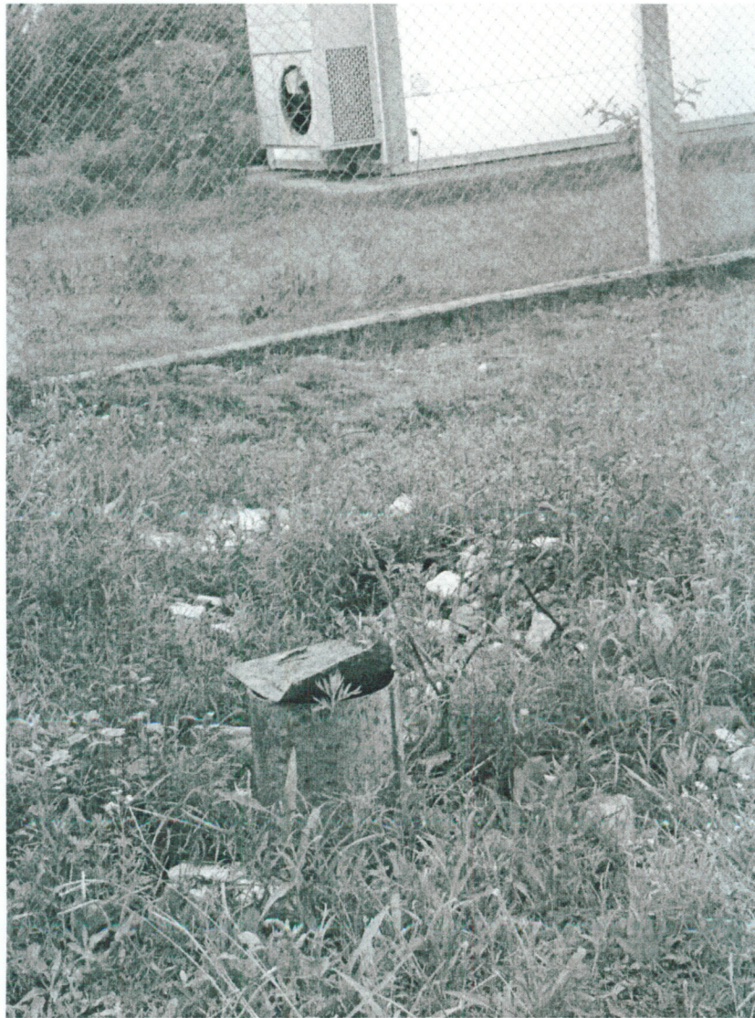
Perforación para instalación de la toma de agua. Boca de Pozo
